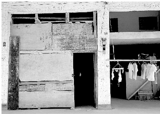
骆效计居住的房子,门和墙是自己用木板修的
