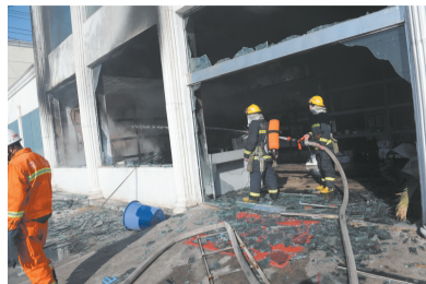
一楼仓库被烧焦。晚报记者 王银廷 图
