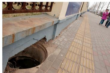
桐柏北路开元银榕小区围墙边的窨井盖接连丢失,里面有电缆线,存在很大的安全隐患。 晚报记者 张翼飞 图
