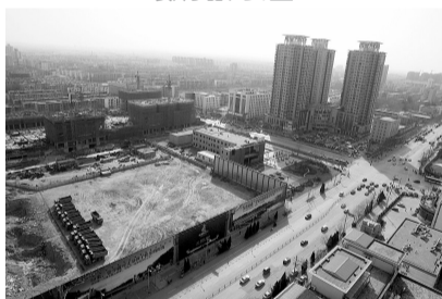
施工中的小岗刘城中村改造项目。
