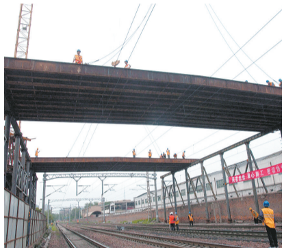
昨日下午,解放路立交跨铁路桥开始进行旋转桥防护设施的搭建。
