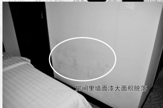
房间里墙面漆大面积脱落
