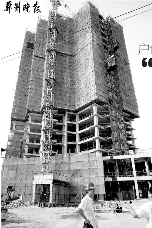
发生丑闻的武昌中心城区余家头三期B座住宅楼
