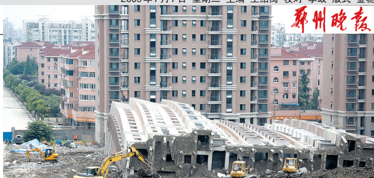
工程车辆正在清理“莲花河畔景苑”小区倒覆楼房附近的土方,防止次生灾害的发生。 新华社发
