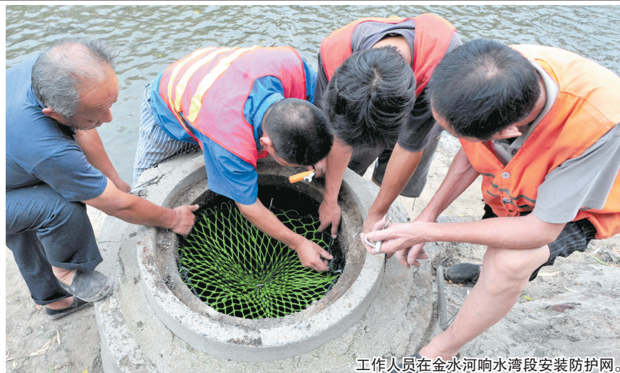
工作人员在金水河响水湾段安装防护网。
