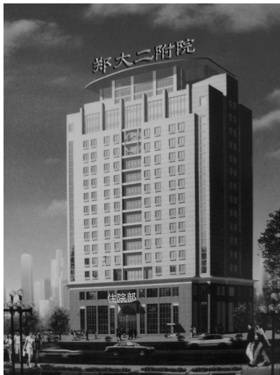
现代化的新病房大楼
