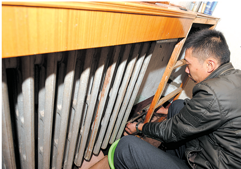
工人正在修问题暖气
