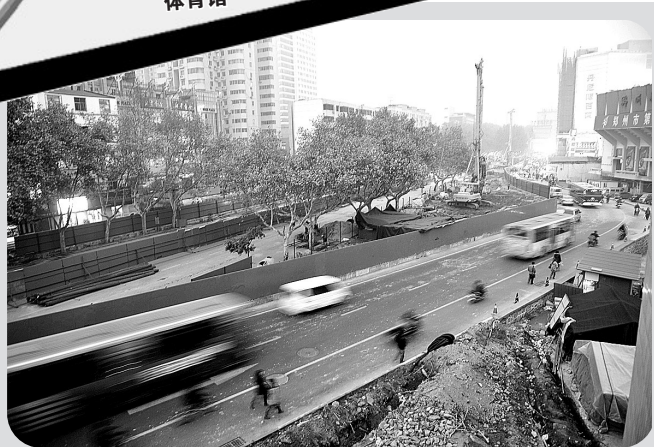
昨日,人民路地铁口已开始封闭施工。 晚报记者 白韬 图
