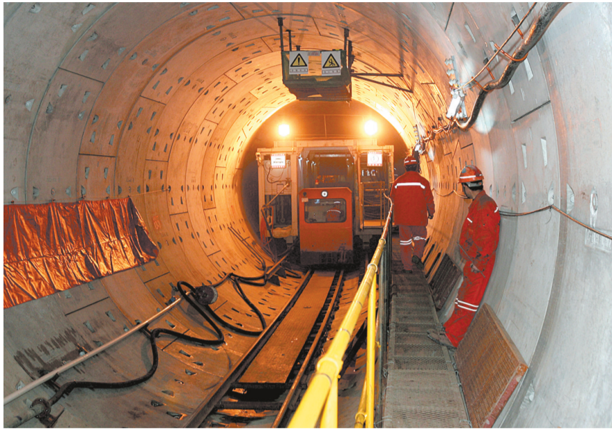
技术人员加班加点进行施工作业。
