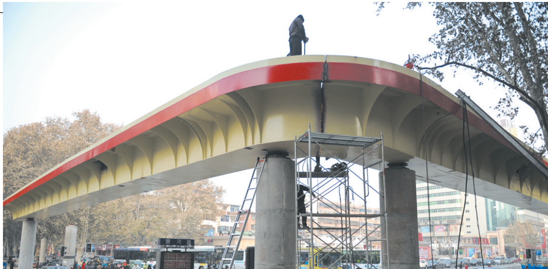
昨天,记者在黄河路与文化路交叉口看到,一座环形立交桥正在紧张施工。该工程建成后,将极大地缓解该路口行车的现状,方便居民出行。
