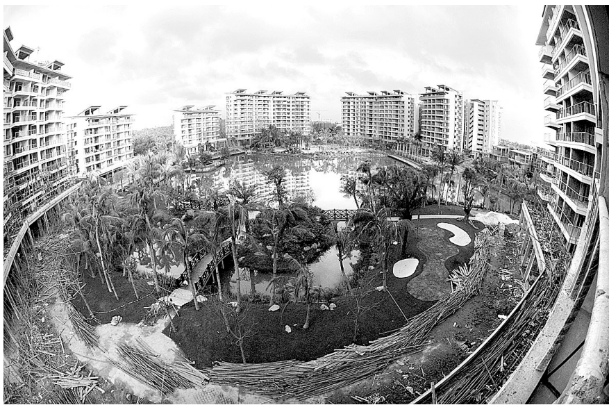
海南省琼海市博鳌千舟湾旅游度假区在紧张建设中(2009年12月摄)。
