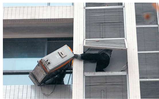
空调主机是拆下来了，可人却被困在8楼的平台上。
