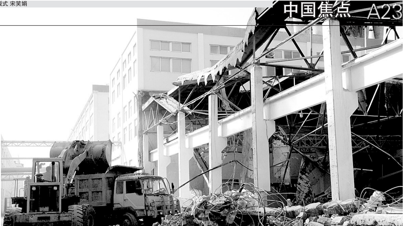
工程机械正在清理燃爆事故现场。新华社发
