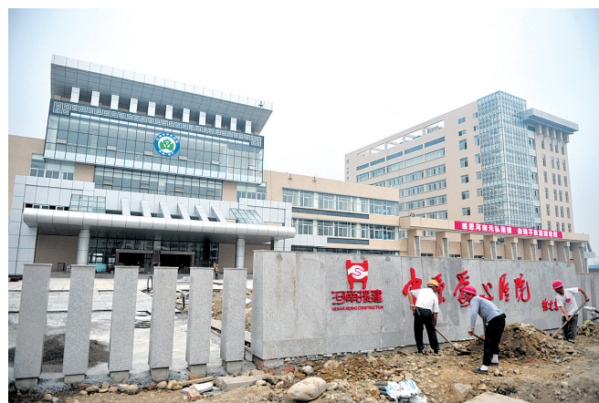
中原爱心医院项目正在进行收尾工作。
