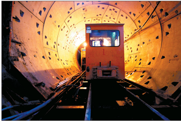
◀临时轨道上跑的“小火车”将材料运进隧道，将挖出的土运出隧道外。
