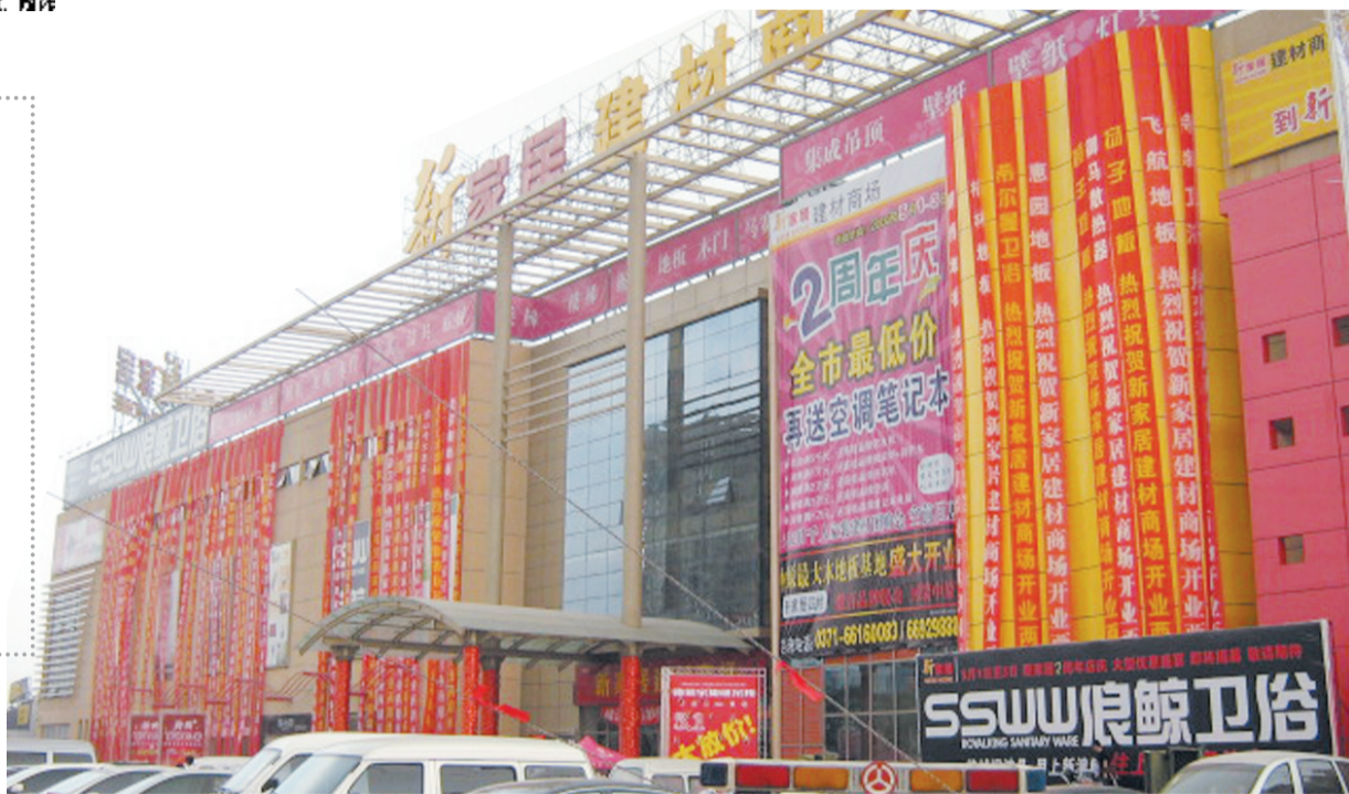
新家居建材商场外广场
