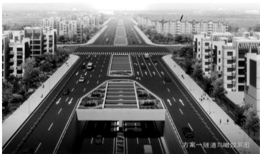
京广路下穿长江路—航海路组合隧道
