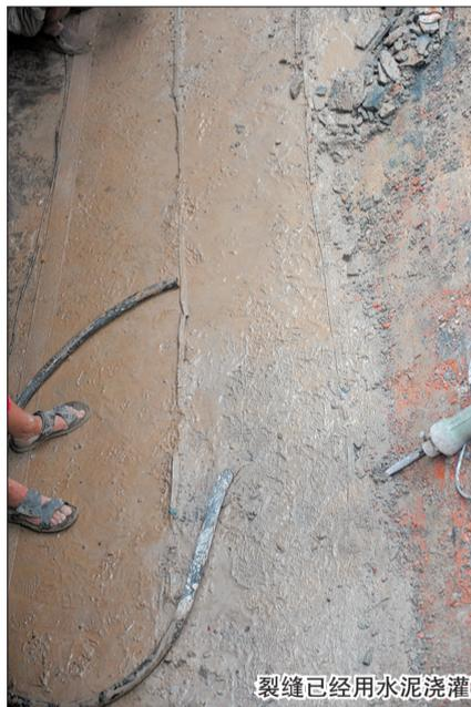
裂缝已经用水泥浇灌
