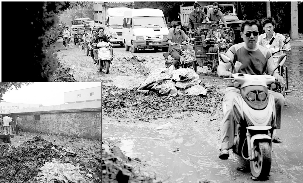
未整治前的药厂街,路两边垃圾堆积如山。
