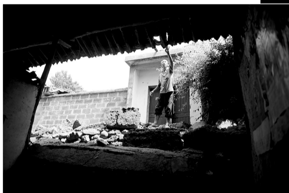
▲刚被村干部拉出房子,这墙就塌了。
