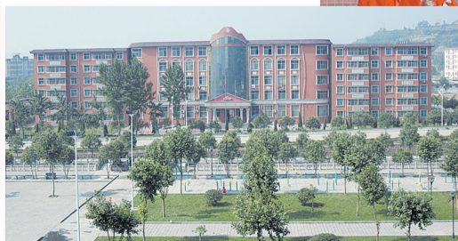
这是小里河村投资 1800 万元建设的鑫旺中学
