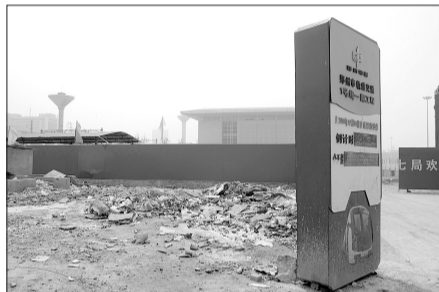
太和路上,临近郑州火车站西出站口的某施工工地的倒计时牌后面隐藏着大量生活垃圾。
