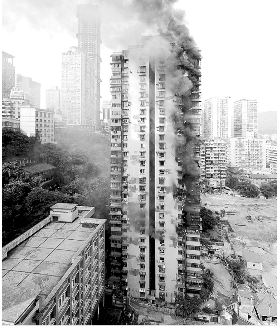
8月9日16时30分左右,重庆市渝中区巴县衙门社区一幢30多层的居民楼发生火灾,大火从9楼燃起,迅速向上蔓延至顶层。截至昨晚记者发稿时,已有20多辆消防车和百余名消防官兵赶赴现场灭火,没有接到人员伤亡报告。 新华社发
