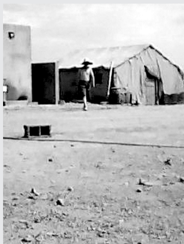
黄沙漫漫的施工现场
