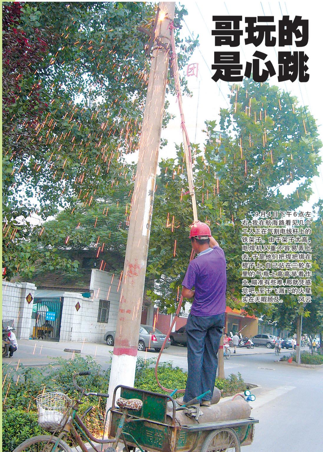
9月4日下午6点左右,我在航海路看见几个工人正在气割电线杆上的铁架子。由于架子太高,电焊机又重不容易弄上去,于是他们把焊把绑在棍子上,自己站在三轮车里的气瓶上高高举着作业,瞄准有些难,那就凭感觉吧,至于飞溅下的火星实在无暇顾及。 风云
