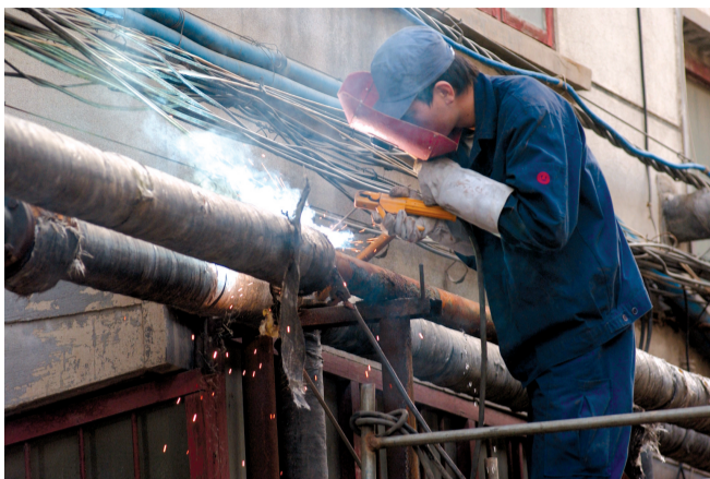
中原环保西区供热分公司主动上门,为小区更换管道、焊接维修。
