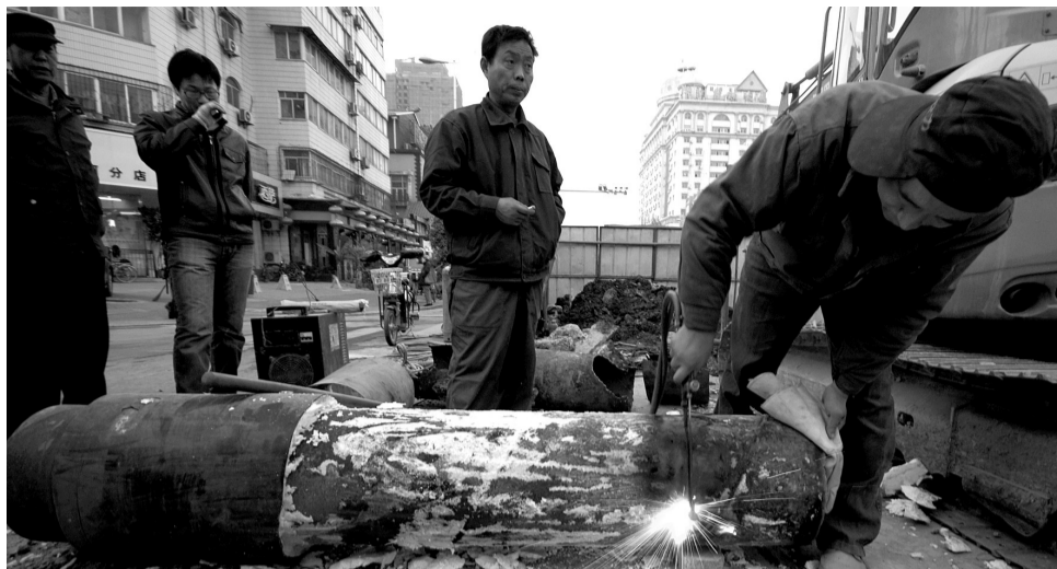
昨日,在桐柏路伊河路口,工人正在紧张地对爆管的供热管网抢修。
