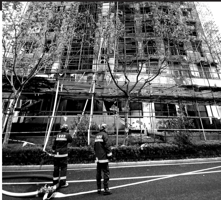
16日,消防人员在发生特大火灾事故的高层住宅楼下进行清理。 新华社发
