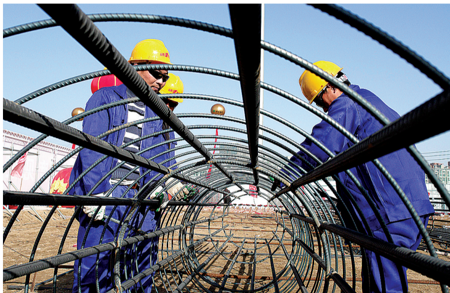
一建筑工地上，工人正在紧张施工。
