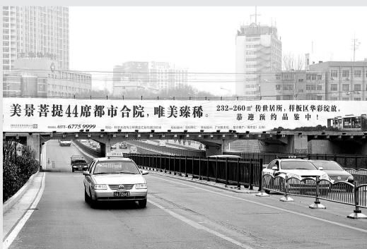
金水路下穿铁路扩孔工程
