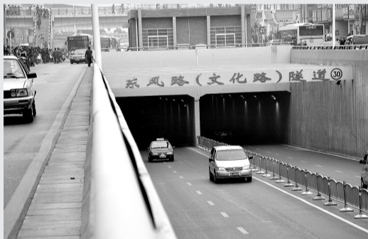
东风路文化路下穿隧道
