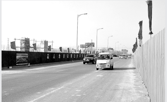
郑开大道与京港澳高速互通式立交正在建设
