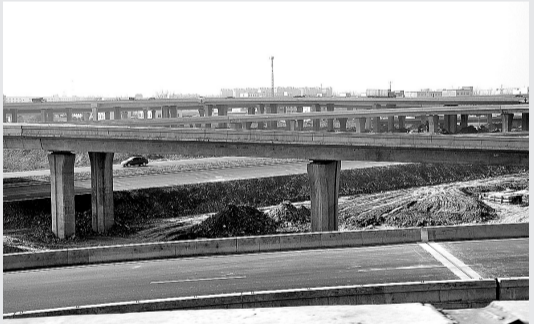
花园口互通式立交桥主线通车
