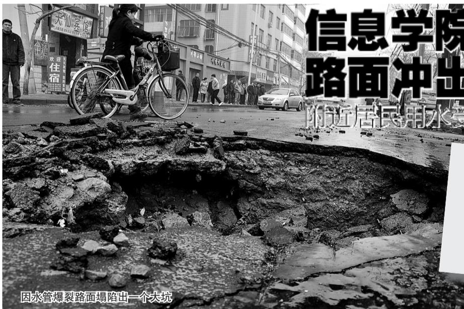
因水管爆裂路面塌陷出一个大坑
