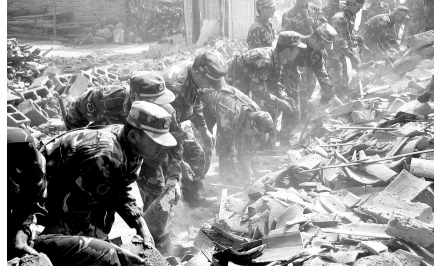
救援人员在地震现场拆除危房。
