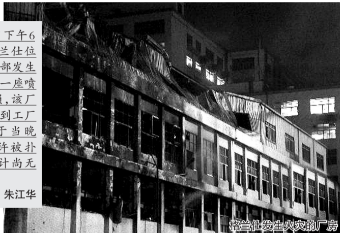
格兰仕发生火灾的厂房
