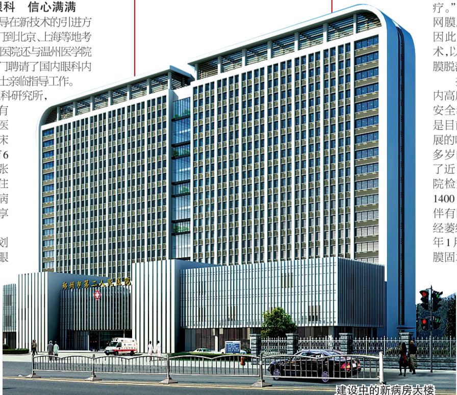
建设中的新病房大楼
