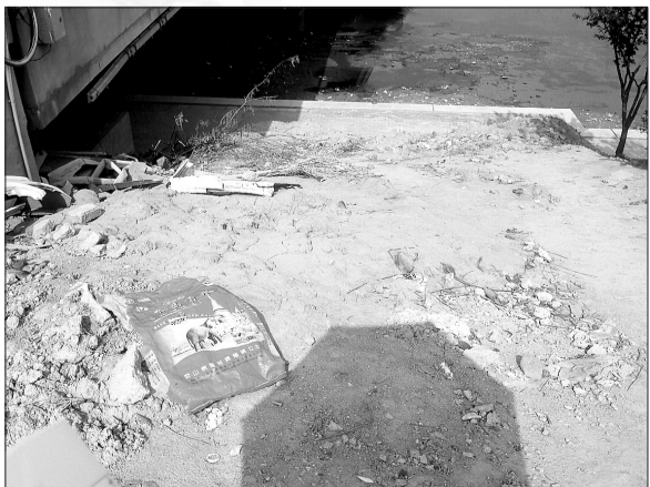
农业东路桥下有建筑垃圾堆积
