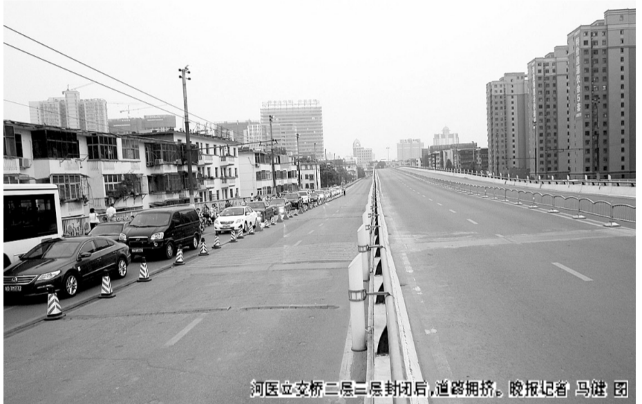
河医立交桥三层三层封闭。晚报记者 马健 图
