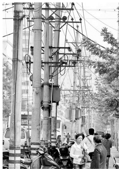
经八路曾被称为“线杆路”(资料图片)
