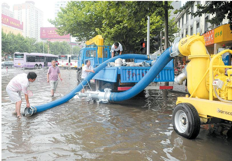
昨天,市政部门首次出动进口的移动排水设备。这种设备一小时能排除1400立方米水。机器上有3个粗大的水管,两个小的进水,一个大的出水,出水口可以外接几个出水口。
