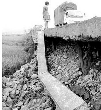
日前,某网站论坛上出现一个帖子,称凉山境内某段108国道坍塌,靠几根木桩撑起。记者8月16日现场采访获悉,该路段近年来受重车碾压,坍塌了3米左右,目前正在落实维修加固方案。
