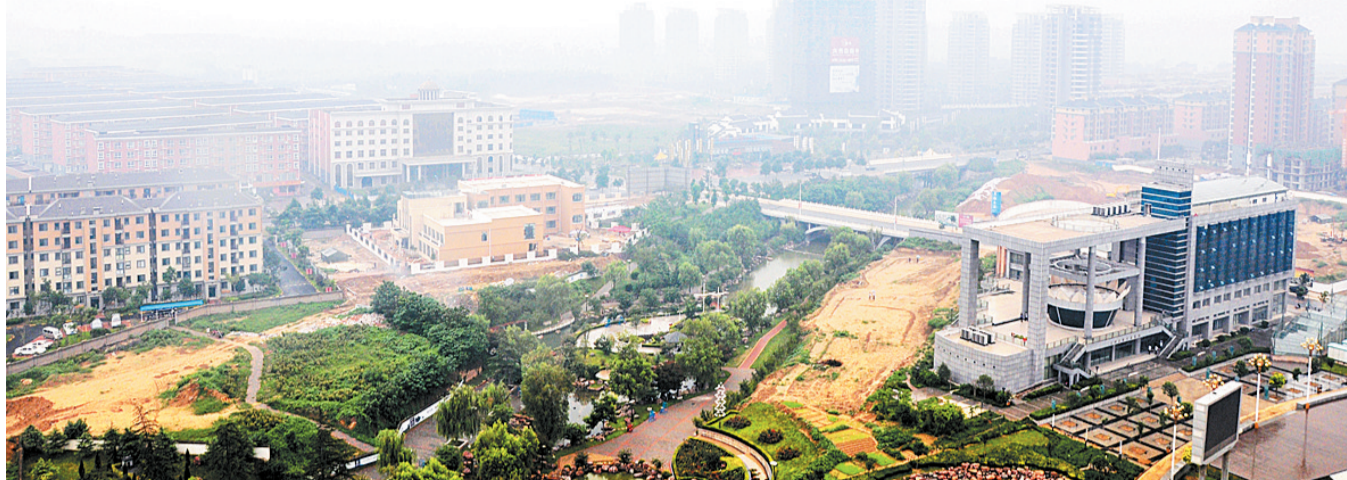
建设中的上街区街景
