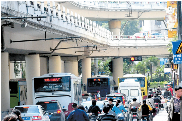
红灯时间过长,造成路口各方向排队拥堵。
