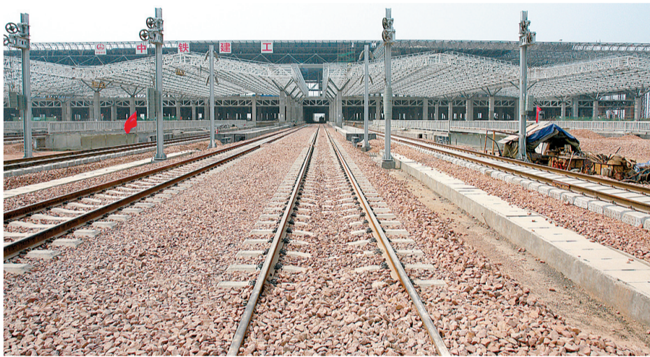
正在建设的新郑州东站。 晚报记者 马健 图
