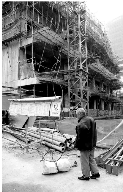
工地上,一名不戴安全帽的工人正在作业。
