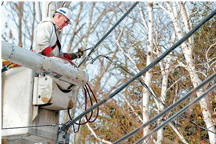
在马萨诸塞州,一个国家电网电力线路工人正在进行电力抢修。
