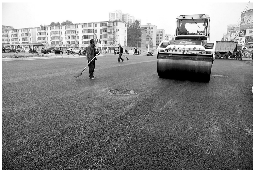
航海路南京沙路段,工人们正在紧张地进行道路铺设。
